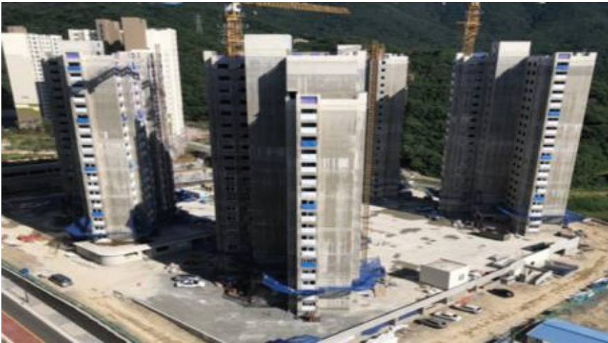
〈그림 3-5〉 거제시 양정동 ‘반값 아파트’ 임대주택 공사 현장
