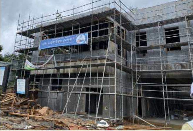
▲ 공사현장 전체에 부패신고채널 현수막 게첨
